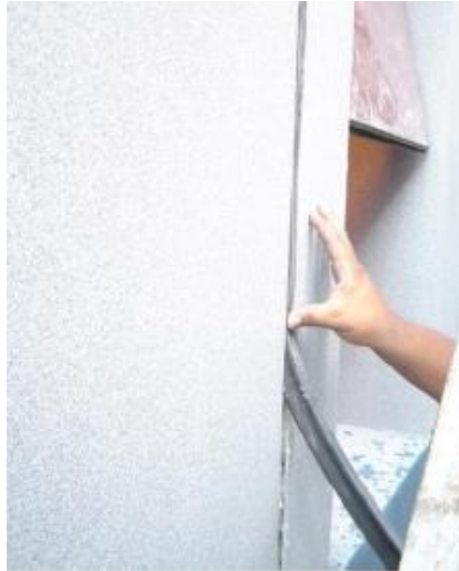
Aplicação de um selante pré-formado em uma junta previamente tratada.
